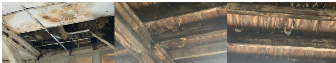
Plancher bas du 2 ème étage dégradé par Trechispora farinacea , Serpula lacrymans et Coniophora puteana
