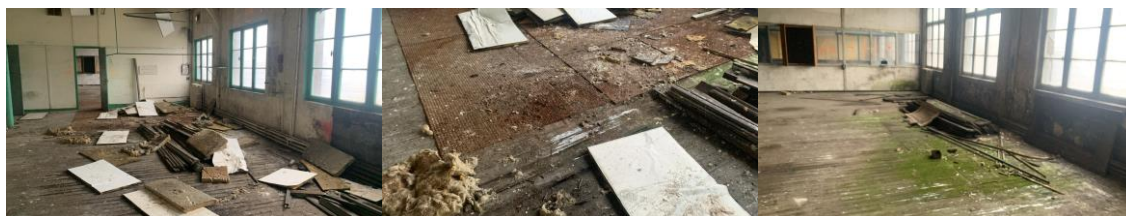
Plancher bas du 1 er étage dégradé par Trechispora farinacea , Donkioporia expansa
